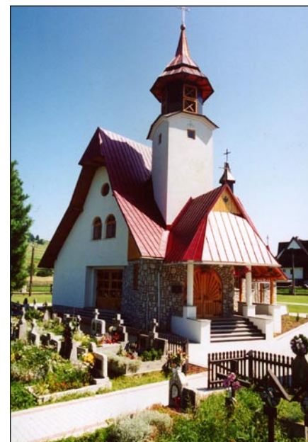
Kościół PW. Trójcy Świętej w Czarnej Górze rozbudowany w latach 1997-2000, fot. J. Budz
