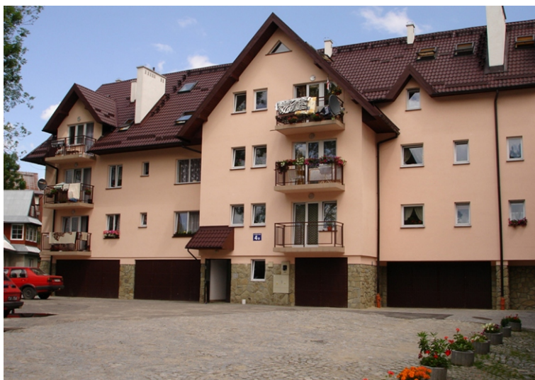
Nowe skrzydło budynku Zakopiańskiego TBS przy ul. Cicha Woda 4b
