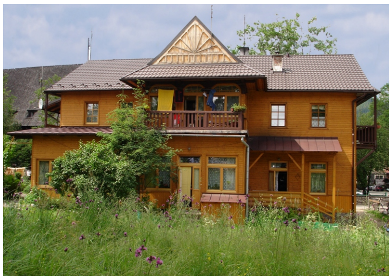
Nowe pokrycie dachowe i elewacja budynku przy ul. Zaruskiego 6
