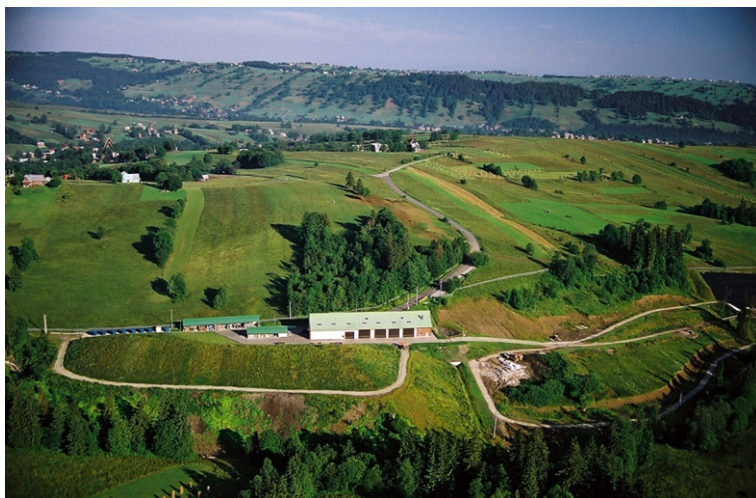
Zakład Utylizacji Odpadów Komunalnych „Zoniówka”
