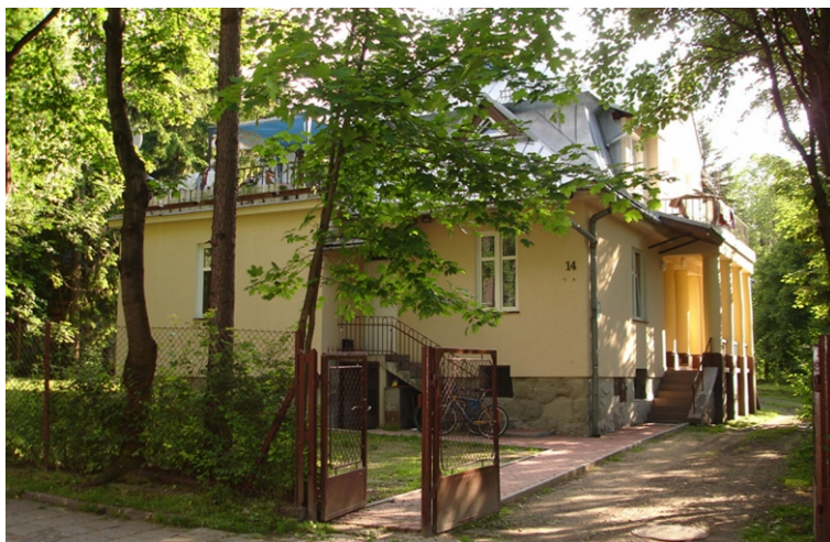
Widok budynku od strony ulicy - Droga do Białego 14
