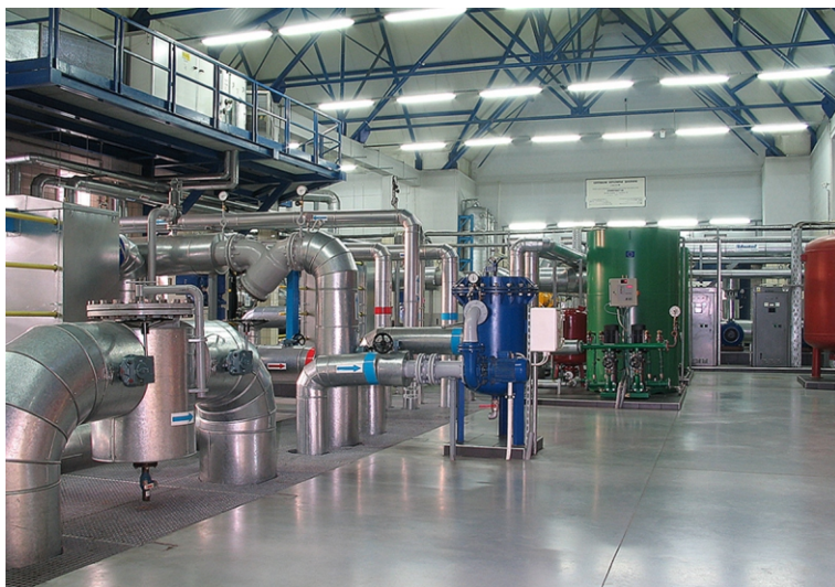
Centralna kotłownia geotermalna ul. Nowotarska
