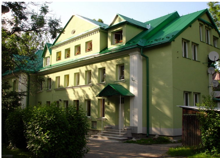
Zachodnia elewacja budynku przy ul. Staszica 13
