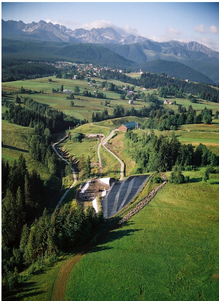
Zakład Utylizacji Odpadów Komunalnych - Zoniówka
